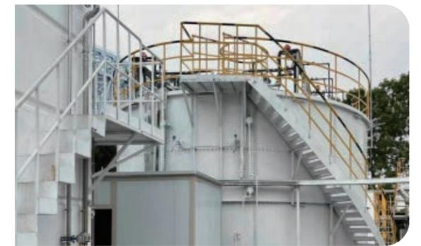
华润环保利用高效全混自流式厌氧反应器，实现建设低成本、沼气高转换、运行低能耗
