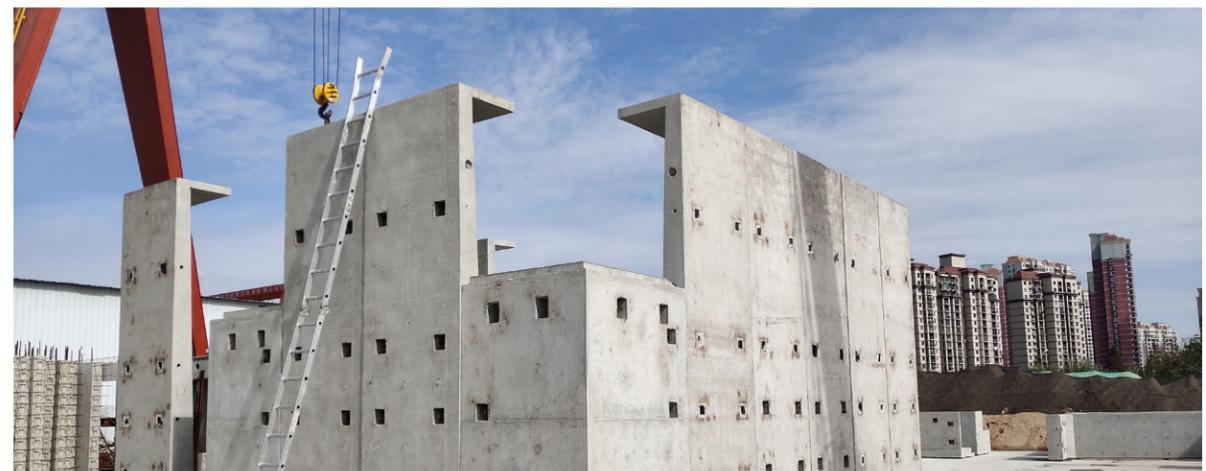
装配式混凝土废水处理池体
