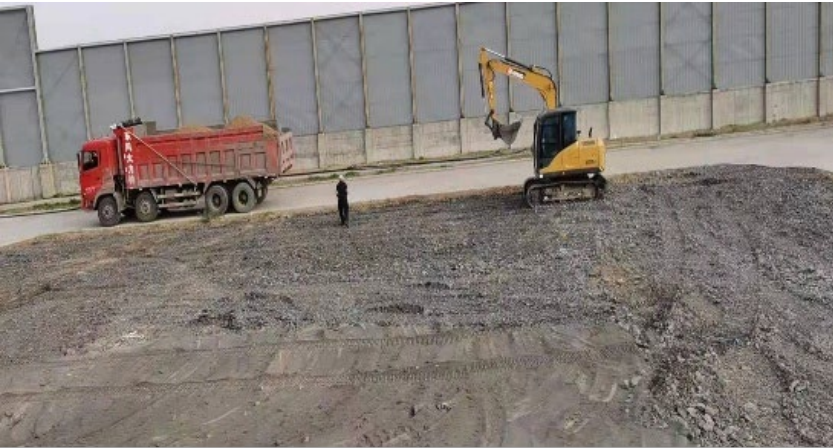
快速复绿修复技术准备阶段：煤矸石土壤消纳
