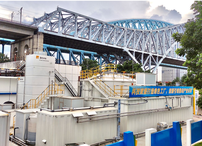
华润环保 - 华润雪花科技创新示范基地
